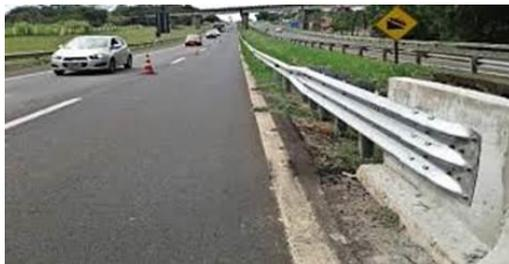
Em cada ponte será necessária a implantação de 4 conjuntos da defesa tripla. Considera-se um conjunto para cada lado da ponte, na entrada e outro na saída da ponte.
