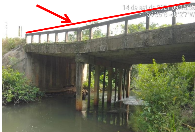
FOTO 03 e 04: O apoio intermediário da ponte sofreu rebaixamento das suas estacas. Foram instalados entre cada estaca uma peça de madeira para reforçar o apoio e retardar esse rebaixamento.
