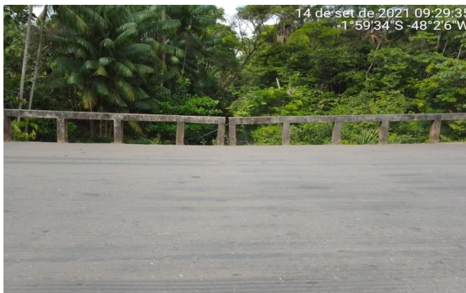
FOTO 01 e 02: A ponte está localizada na PA-252. Mede 14 metros. Percebe-se que aconteceu um recalque no tabuleiro justamente no apoio central da ponte.
