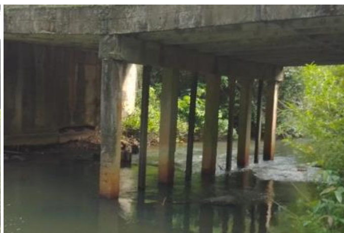
FOTO 03 e 04: O apoio intermediário da ponte sofreu rebaixamento das suas estacas. Foram instalados entre cada estaca uma peça de madeira para reforçar o apoio e retardar esse rebaixamento.
