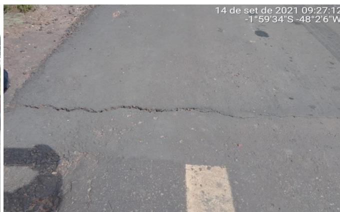
FOTO 05 e 06: metade do guarda corpo existente está destruído e percebe-se o movimento do encontro do tabuleiro com laje de transição após o recalque no centro.
